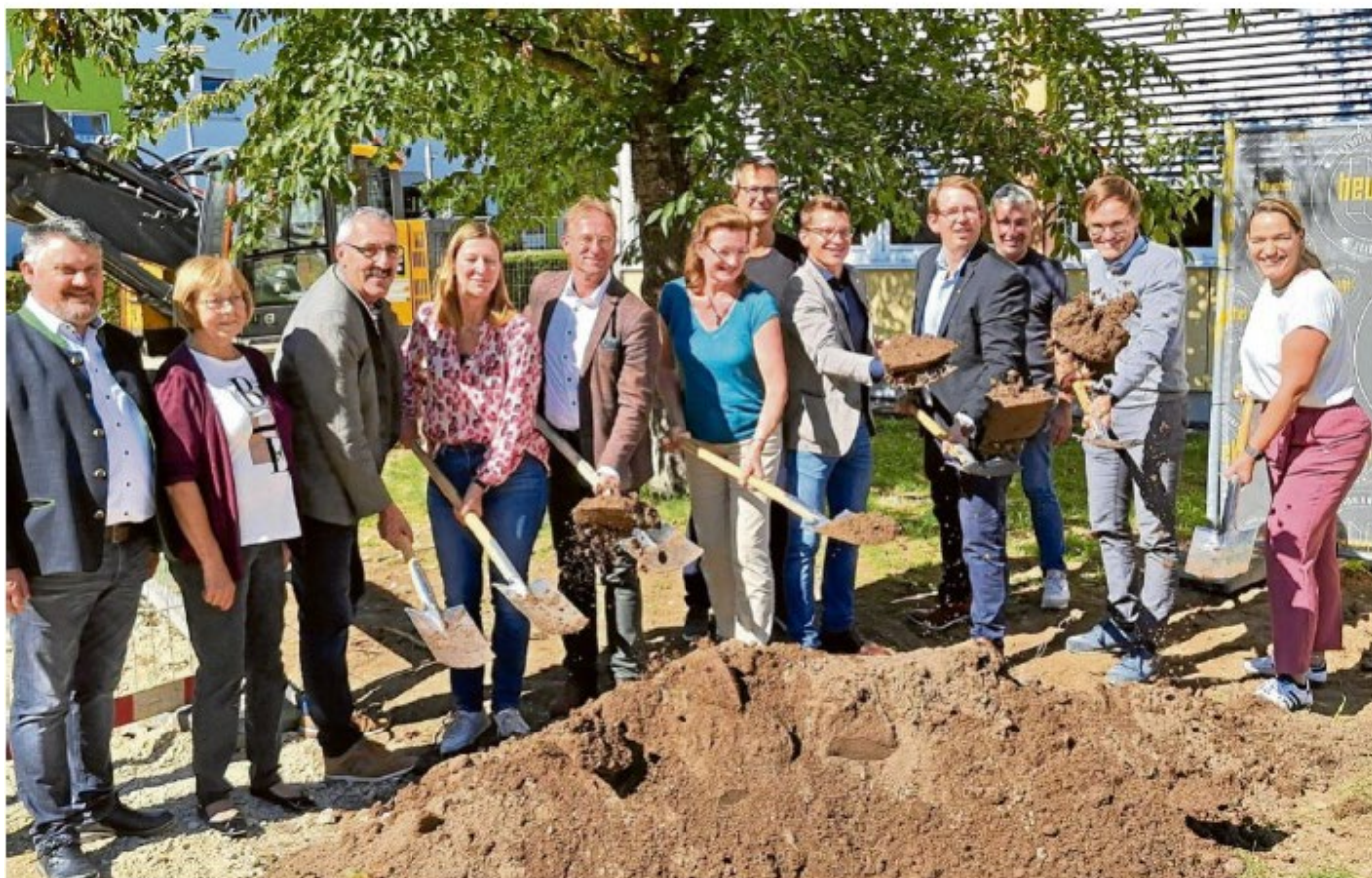
Mit dem Spatenstich ist der Startschuss für den Erweiterungsbau an der Schillerschule gefallen. Foto: Bernd Schied
